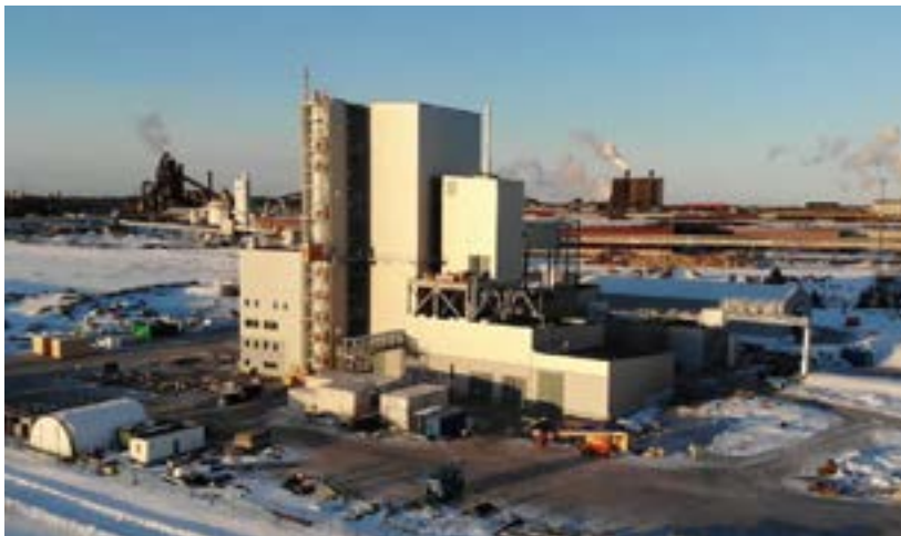
Hybrits försöksanläggning under uppförande i Luleå 2020. Foto: Anders Frick/Wikimedia Commons CC BY-SA 4.0
