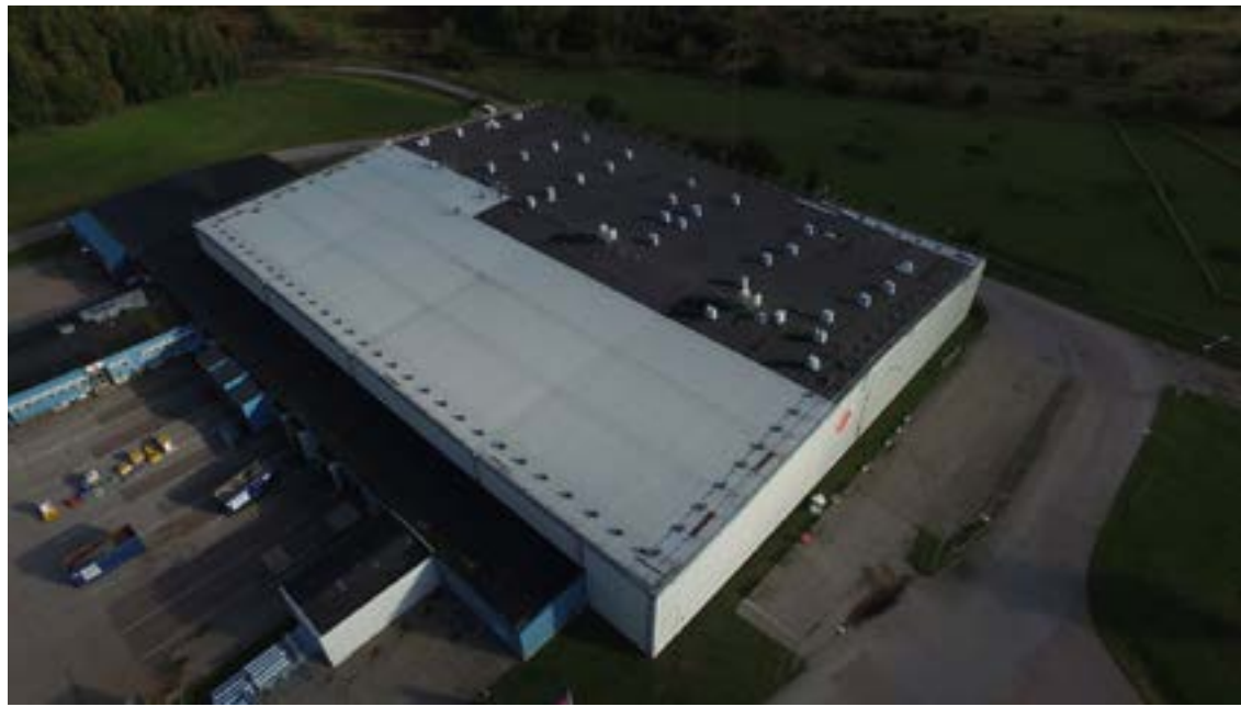
Vi hade förmånen att få installera ett tätskikt på Kavil´s fabrik i Eslöv
